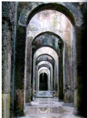
Scorci interni della Piscina Mirabilis
