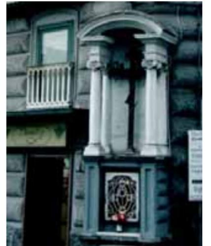
Il terzo livello risulta ugualmente scandito da tre porzioni grafiche: la zoccolatura, che posta sulla cornice marcapiano, è definita da una decorazione geometrica a rombi; la muratura centrale a bugne lisce continue; la terza porzione con una ulteriore decorazione geometrica.
